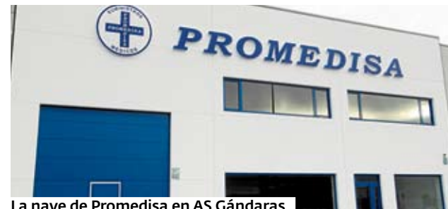
La nave de Promedisa en AS Gándaras.
